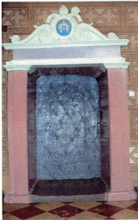
Portal do zakrystii północnej z herbem bpa Piotra Tylickiego z czasów odbudowy kościoła (1604-1608)
